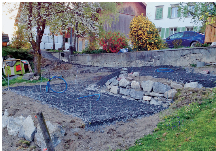
In Jenins werden die Schlaffässer beim Hof von Familie Eggenberger installiert.
